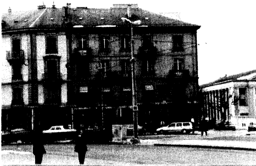
C'est dans cet immeuble, Place Neuve à Genève que sont créés les aménagements cyclables du bout du Lac.
